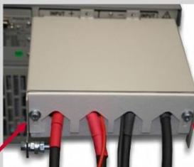
**Hintere Abdeckung über die Kabel schieben und anschrauben**
